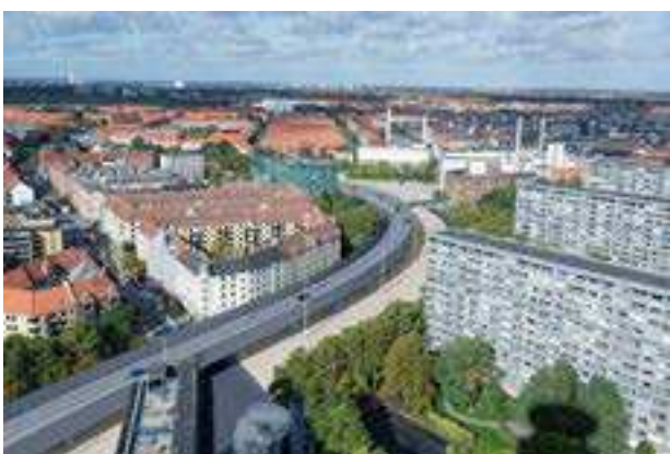
Figur 11. Eksisterende forhold (øverst) og fremtidige forhold i henholdsvis nordlig og sydlig løsning
