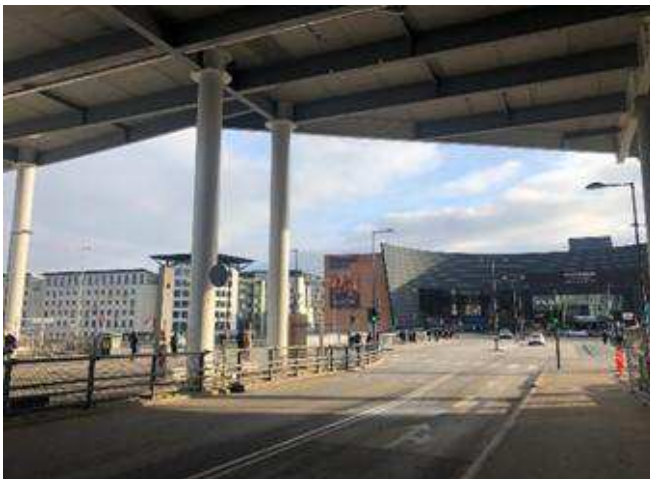
Figur 1 Billede af aktuelle forhold under det nye tag over Dybbølsbro ved IKEA. Dette er et af mange udviklingsprojekter i området, som enten er i gang med at blive bygget eller planlagt.
