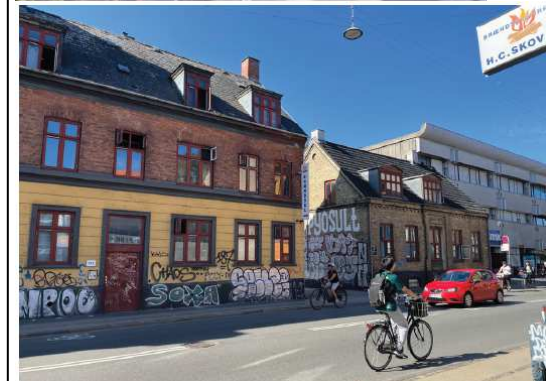
Nordre fasanvej 273 og 275 med Schou-Epa i baggrunden (Fra forhåndsdialogmaterialet)
