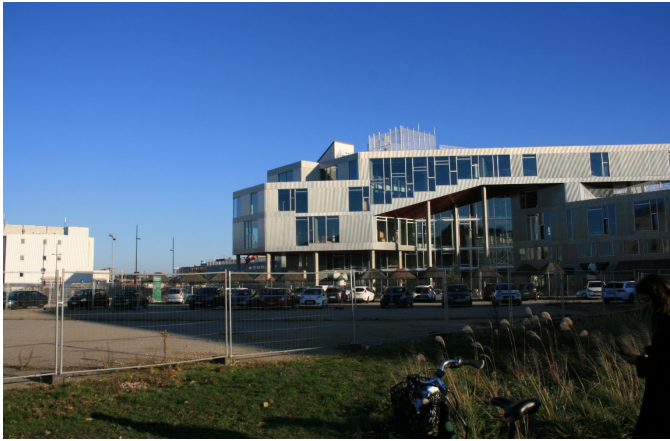
Skolen i Sydhavn umiddelbart over for byggegrunden.
