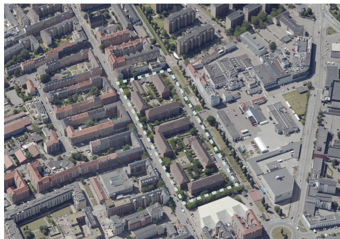
Luftfoto af Støberigården I + II.
