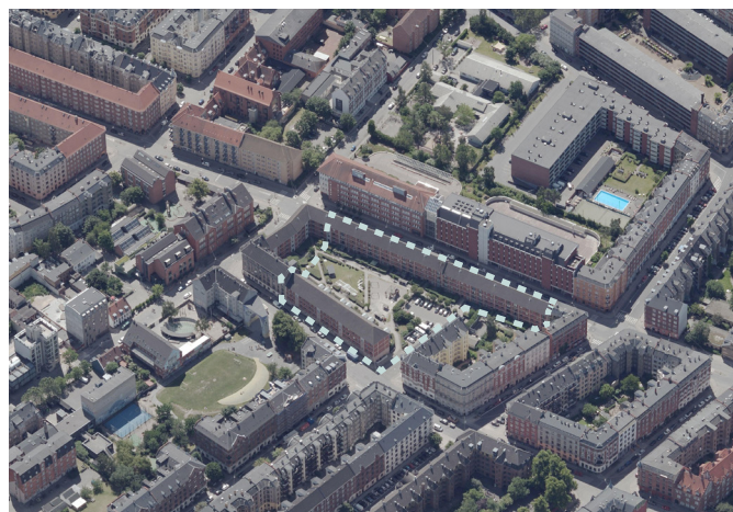
Luftfoto af Bagergården afd. 143 med kig ind i gårdrummet.
