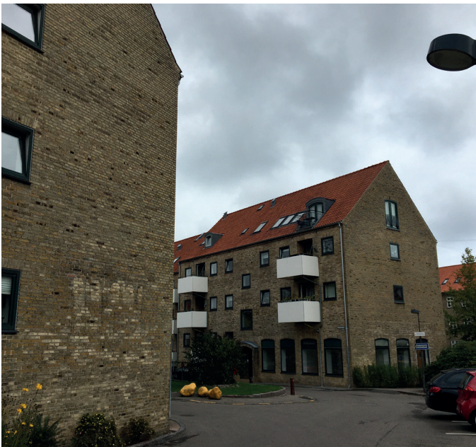
Gavle isoleres og genetableres med matchende sten.
