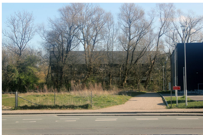
Kig fra Kigkurren mod arealet, hvor der skal etableres en grøn kile. Plejehjem og daginstitution skal opføres til højre herfor, hvor der i dag ligger en midlertidig daginstitution. I baggrunden ses den nyistandsatte Ballonhangar.
