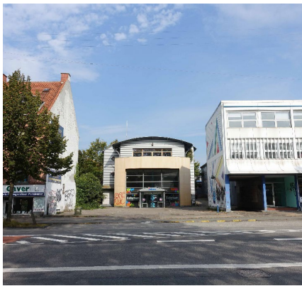
Erhverv mod Frederikssundsvej i hvid plade/malet beton Nabobygning nr. 276 som beige puds og sinusplade. Tagformer er flade, tøndehvælv med tagafslutning øverst
