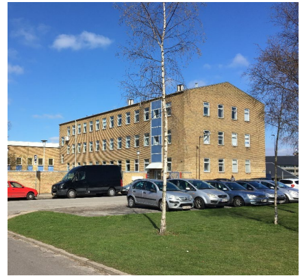
Kobbelvænget 72, samt kranhallen bagved fremstår i gule tegl Med en taghældning på 18°
