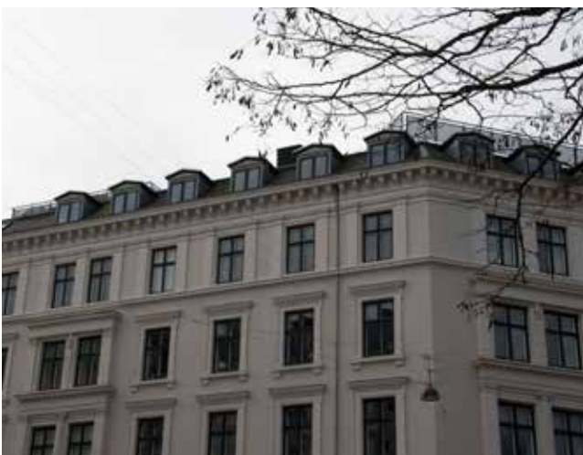
Foto 16. To tagterasser placeret på den flade del af Københavnertaget. Tagterassen til højre er meget synlig, mens tagterassen mod venstre er mere diskret placeret. Det er ønsket, at en tagterasse ikke kan ses fra gadesiden.
