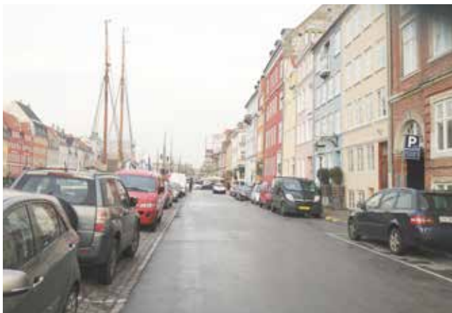
Eksisterende forhold for solsiden af Nyhavns yderside. Der er projekt for omlægning af denne strækning langs Nyhavns solside, som forventes at være afsluttet i 2015. Illustration fra tegnestuen Schönherr.
