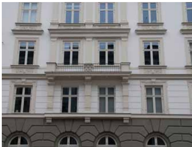
Foto 19. Altan, der spænder over flere vinduesfag, kan i de fleste tilfælde være en mulighed. Den passende længde afhænger i hvert enkelt tilfælde af ejendommens facadearkitektur og beliggenhed.
