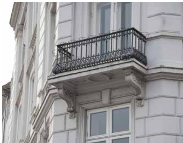
Foto 21. Altanbunden er dekoreret, forkanten er profileret og bunden indgår naturligt med gesimsen.
