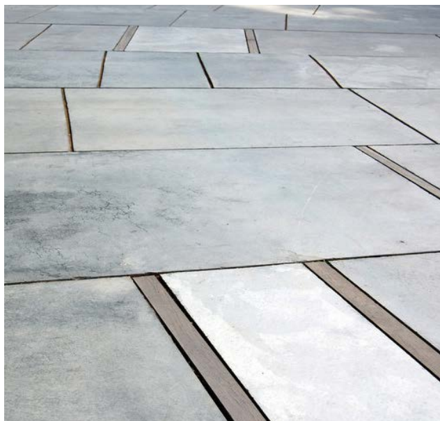
Belægningen ved Tietgens Kollegiet er et eksempel på, hvordan en belægning kan understrege en bygnings form og arkitektoniske skala. Arkitekter: Marianne Levinsen Landskab. Foto: Marianne Levinsen
