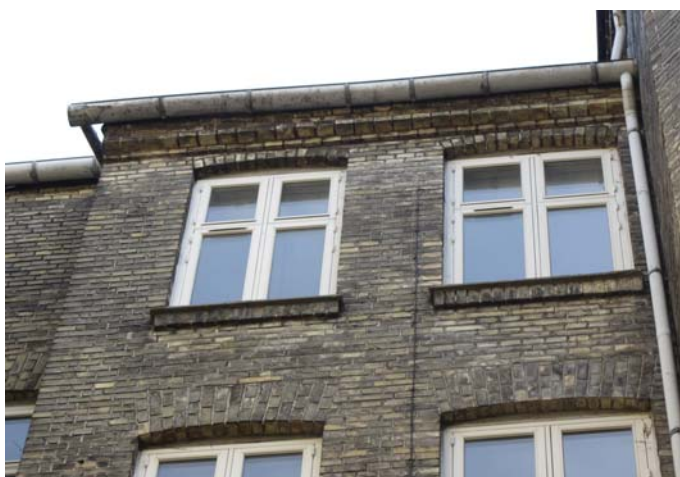
Alle vinduer udskiftes til energioptimerede vinduer
