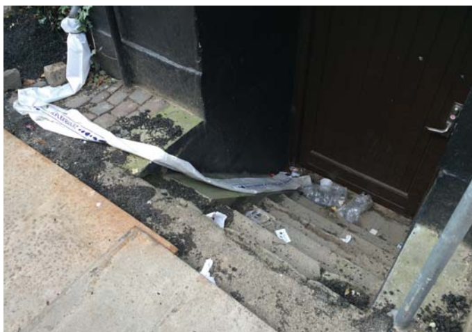
Renovering og fugtikring af kælder og underfacade
