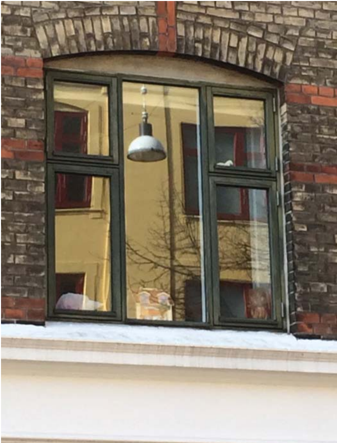
Termoruder med stort energispild udskiftes
