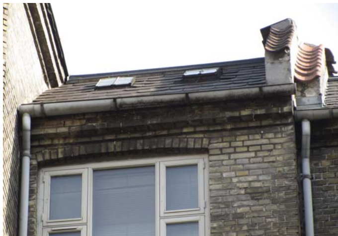
Tagkonstruktion renoveres, og der lægges nyt skifertag
