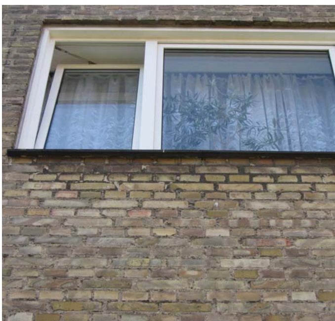
Vinduer og altandøre udskiftes
