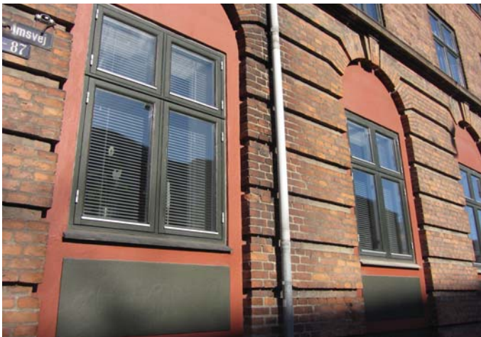
Vinduer udskiftes og lydisoleres
