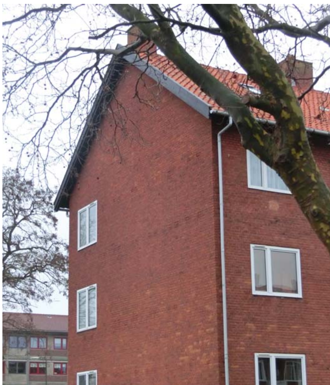
7 fritstående gavle isoleres udvendigt
