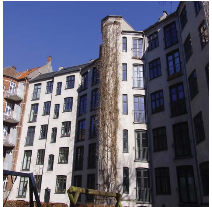
Facade mod gård. Brystninger hulmursisoleres
