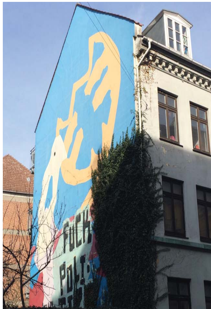
Gavl mod Bangertsgade efterisoleres yderligere udvendigt
