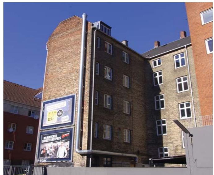
Facade mod baggården. Gavl istandsættes og isoleres
