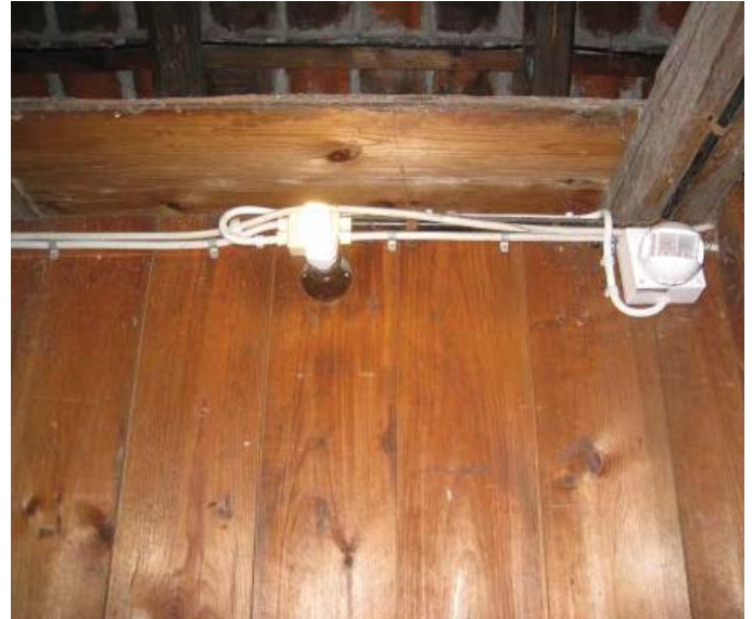
Udskiftning til energibesparende lysarmaturer i kælder
