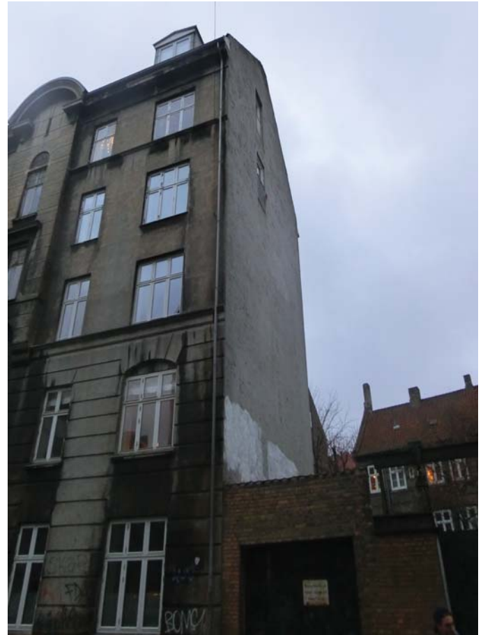
Sidste gavl af i alt fire efterisoleres udvendigt
