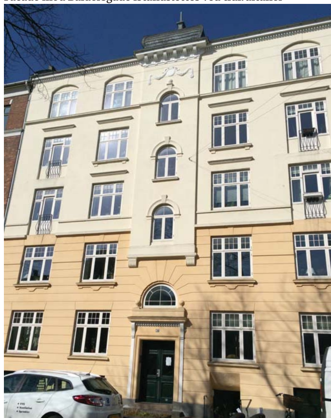
Facade mod Baldersgade istandsættes ved tidl. altaner
