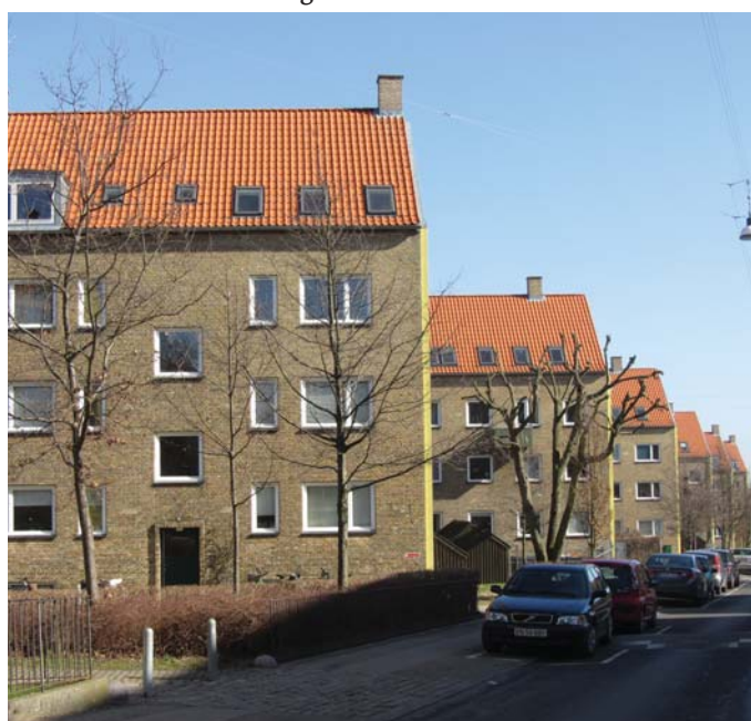
Facade mod Møntmestergade
