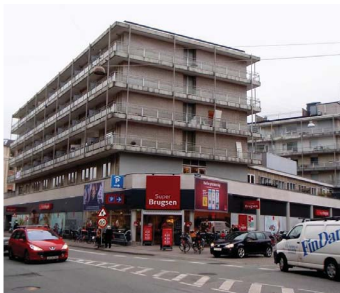
Facade mod Enghavevej. Der laves en helt ny facade udenpå
