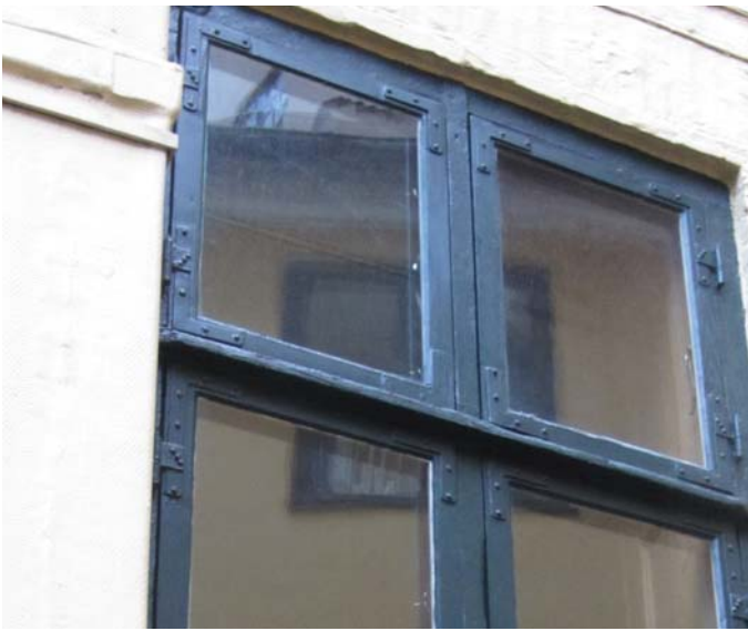
Eksisterende vinduer istandsættes og tætnes
