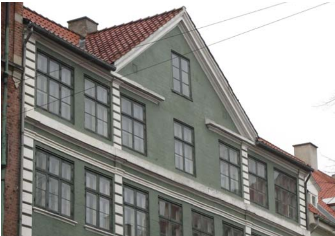
Tag istandsættes og efterisoleres
