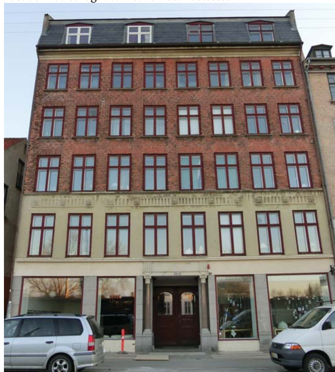
Facade mod Sølvgade. Facader istandsættes
