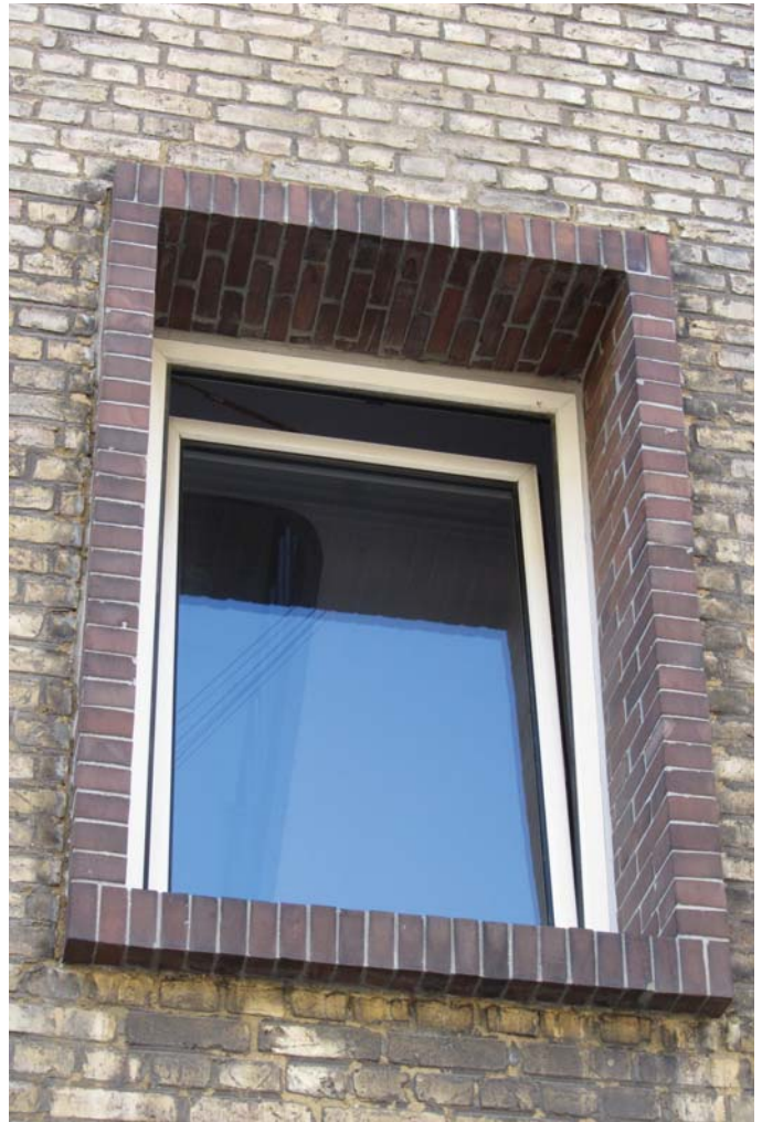
Ældre termoruder med stort energispild
