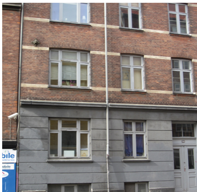
Facaden istandsættes og fugerepareres
