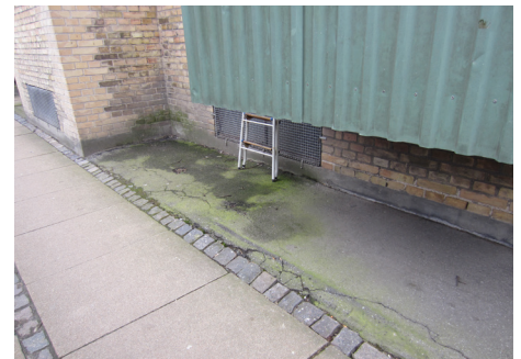
Efterisolering af etageadskillelse mod kælder
