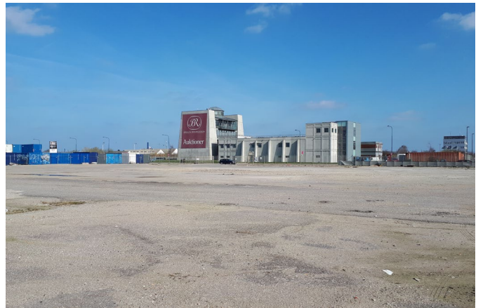
Billedet viser 'Bruun Rasmussens Kunstauktioner A/S' (bygget i 2002) set fra vest mod øst, samt ubebyggede arealer ved Sundkrogsvej.
