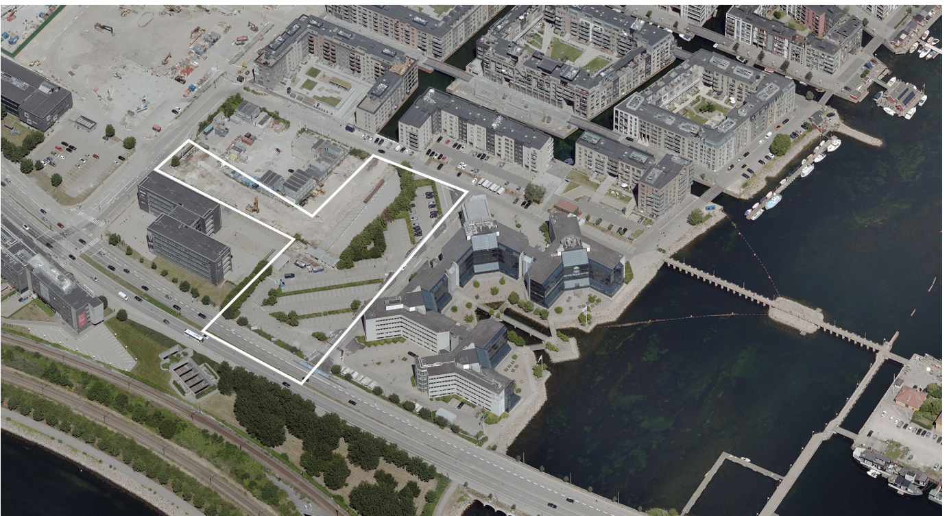
Skråfoto set fra syd mod nord. Nederst i billedet ses Sjællandsbroen, 'Nauticonbygningen' og lokalplanområdet. Nord for (øverst i billedet) er de sidste boligkarréer på Sluseholmen og kanalerne under udbygning. Luffoto: Kortforsyningen, 2019.
