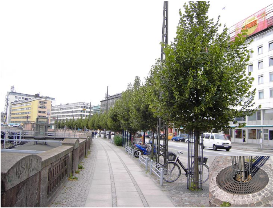
Figur 7: Storbladet lind langs Vester Farimagsgade. Bærelag af gartnermacadam under chausséensbelægningen skaber mulighed for rodvækst under arealer til cykelparkering og fortov. Det lille billede nederst til højre viser, at den åbne jordoverflade er forholdsvis lille (1 m 2 ).
