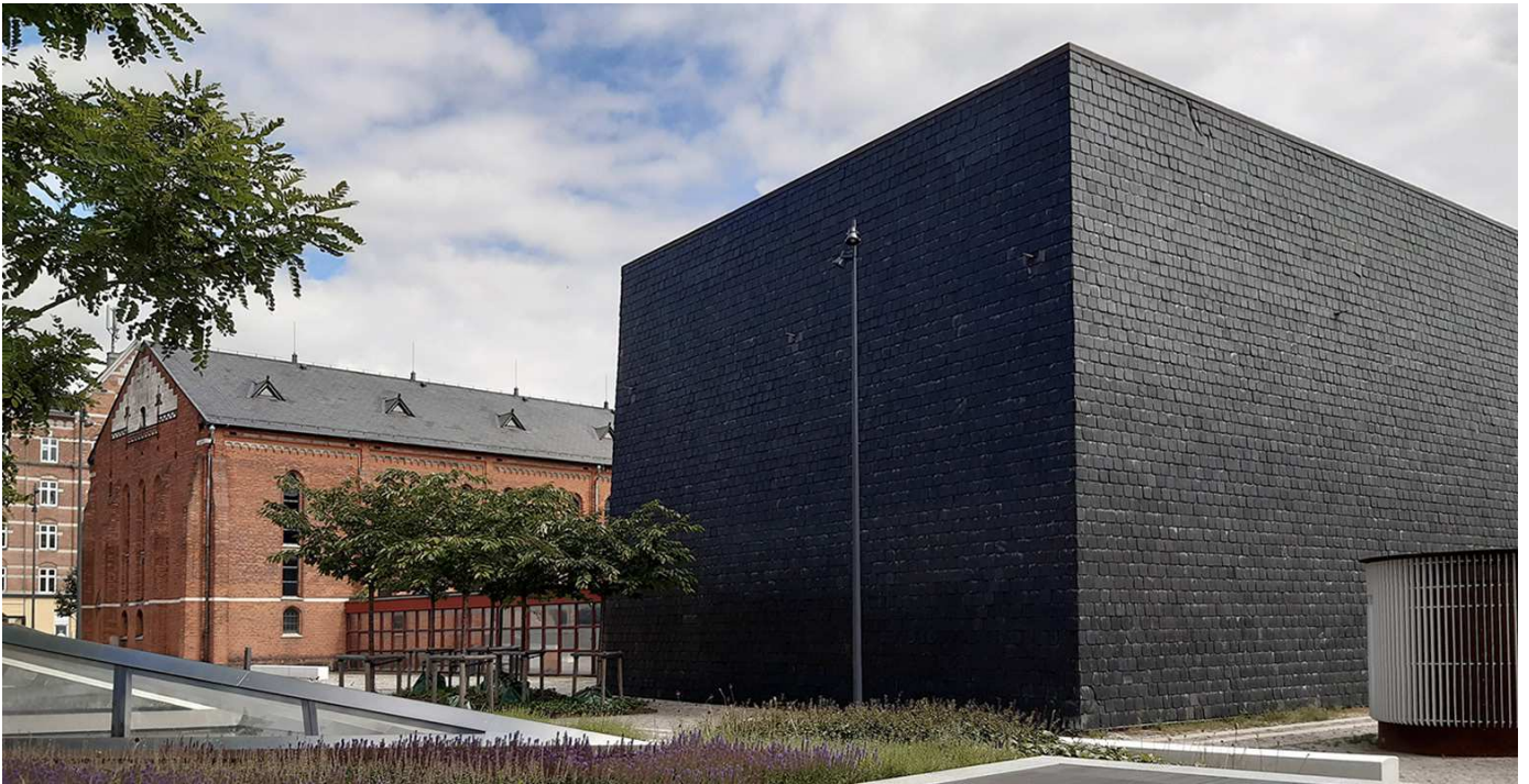
Lokalplanområdet ligger ud til Jagtvej og metroforpladsen. Nyrops arkivbygning (tv.) og Koppels magasinbygning (th.) ligger parallelt med gavl mod pladsen. Nyrops bygning er opført i røde mursten og med et stort sadeltag i skifer. Koppels bygning er tillukket med beklædning i sort naturskifer. Begge fremstår monumentale på hver sin måde og udpeges som bevaringsværdige. Den lavere forbindelsesbygning (administrationsbygning) kan nedrives for at muliggøre nybyggeri.
