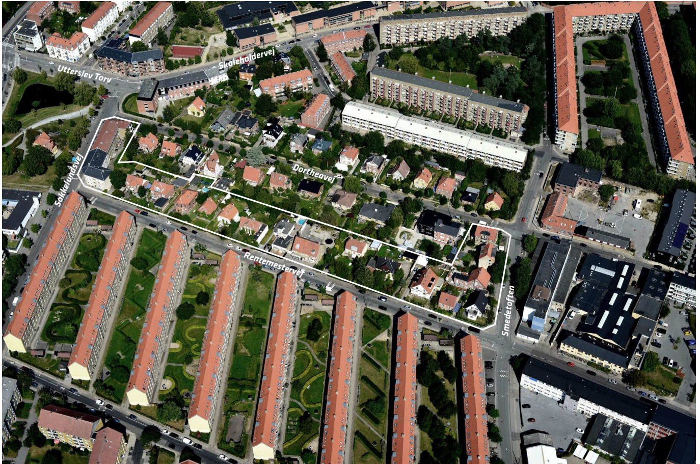
Luftfoto af lokalplanområdet set fra syd
