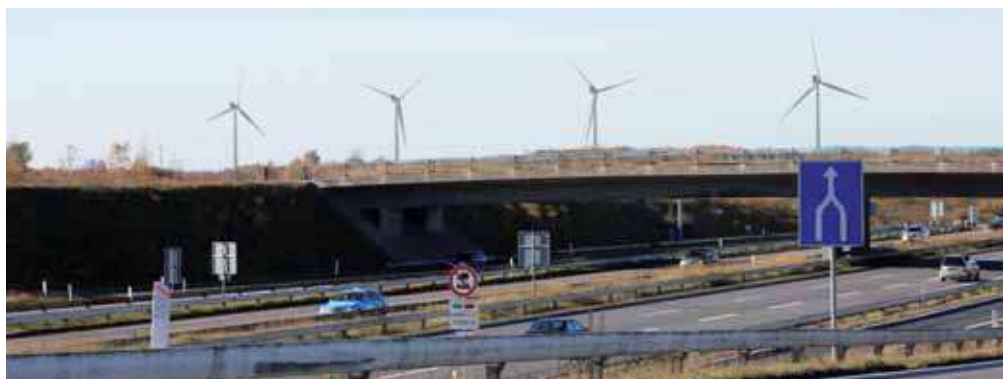
Visualisering K3: Forslag A: Fire vindmøller på 148 m på en linje langs med diget.
