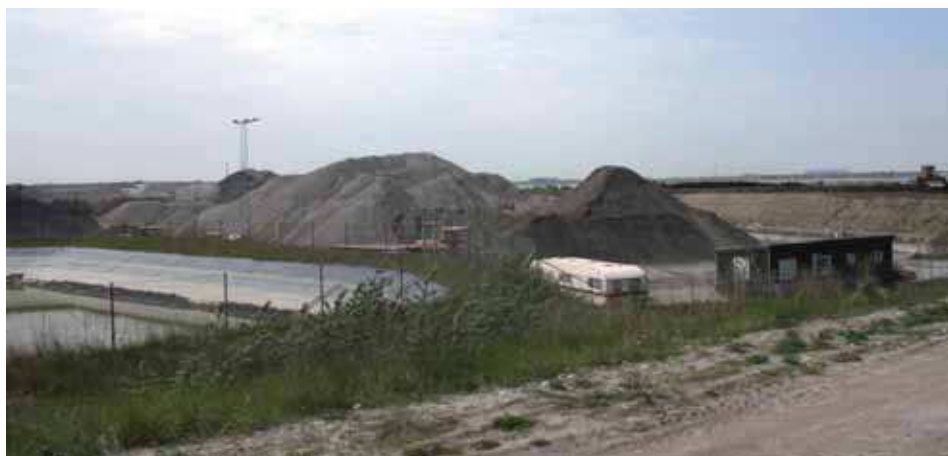
Figur 9.4 Udsigt over Kalvebod Miljøcenter på den vestlige side af broen over E20 ved Fasanskovvej. Kalvebodløbet kan anes i baggrund til højre i billedet.
