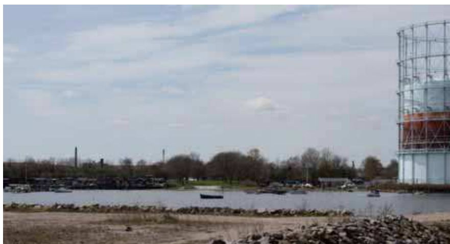
Figur 9.7 Sundby Gasværk til højre i billedet, med haveforeninger i baggrunden og den nye del af Prøvestenen i forgrunden.
