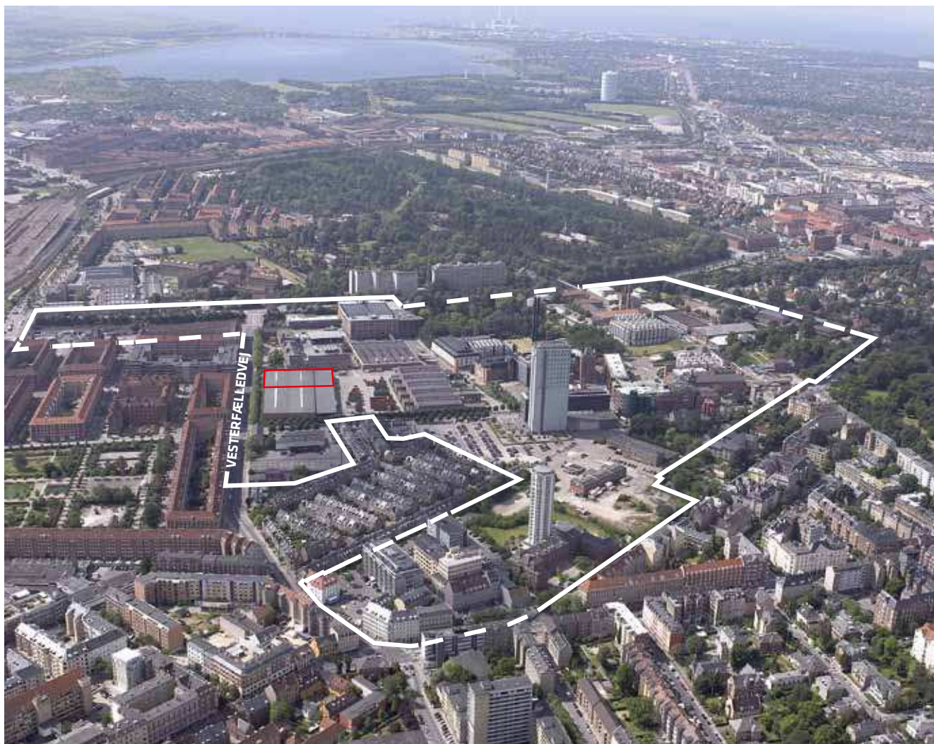
Lokalplanområdet ligger i bydelene Vesterbro og Valby. Den røde streg indikerer den del af bygningen ved Vesterfælledvej, hvor der ønskes etableret en dagligvarebutik.
