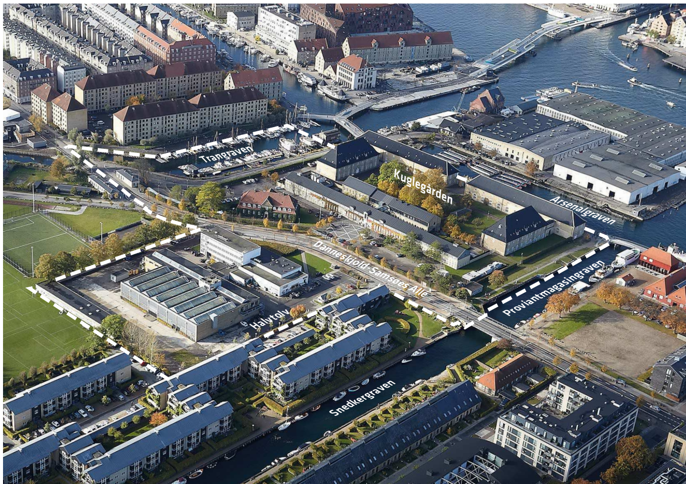
Skråfoto af lokalplantillægsområdet. JW Luftfoto, oktober 2016.
