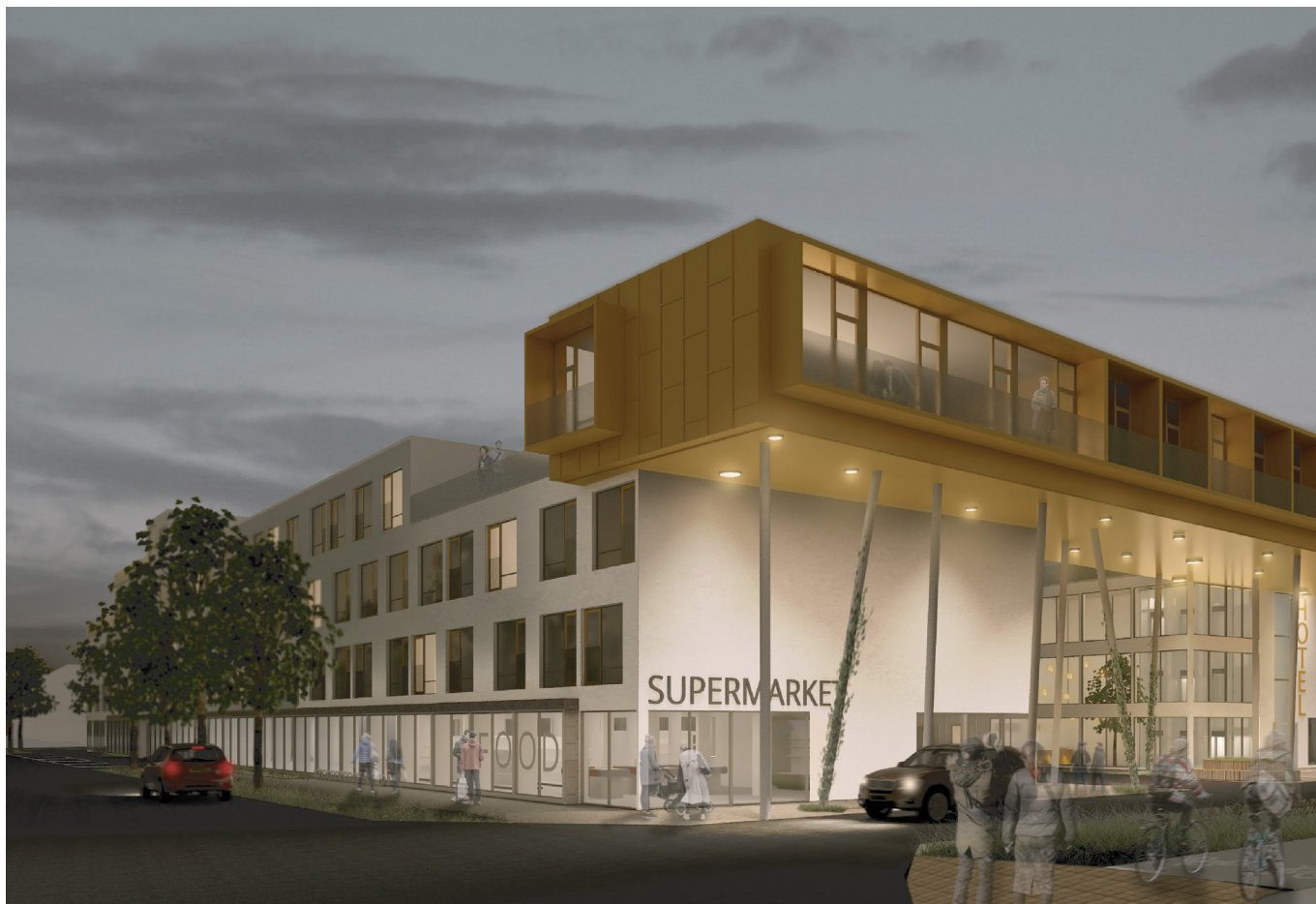
Bebyggelsen set fra hjørnet ved Hedegaardsvej og Jorisvej med den nye forbindelsesbygning, der bæres af søjler og belyser det underliggende byrum. Ill. AI.
