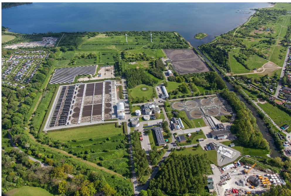
Renseanlæg Damshusåen. Foto: Hviid Photography
