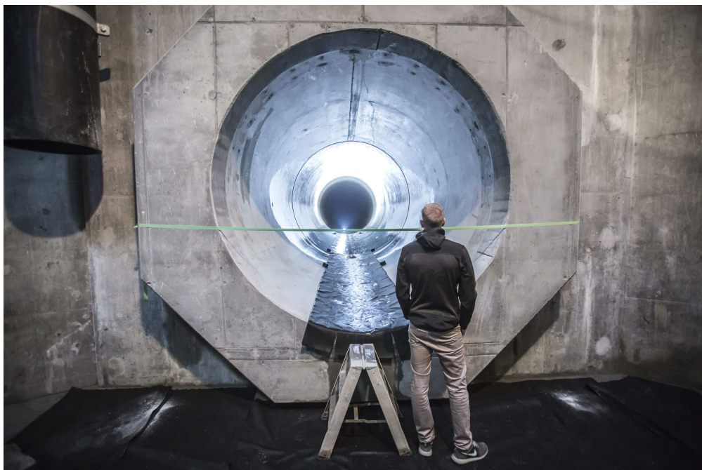
Østerbro skybrudstunnel. Foto: HOFOR
