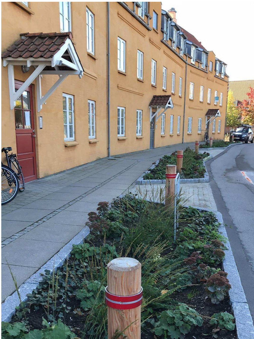
Vejbed til forsinkelse og nedsivning af regnvand på Erik Ballings Vej. Foto: Louise Madsen
