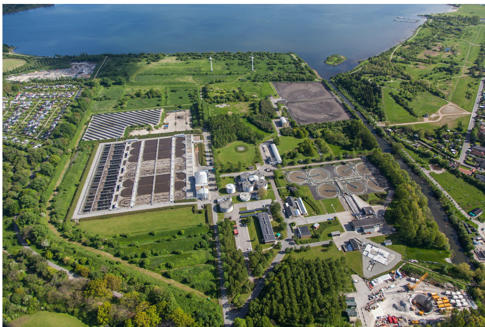
Renseanlæg Damshusåen. Foto: Hviid Photography
