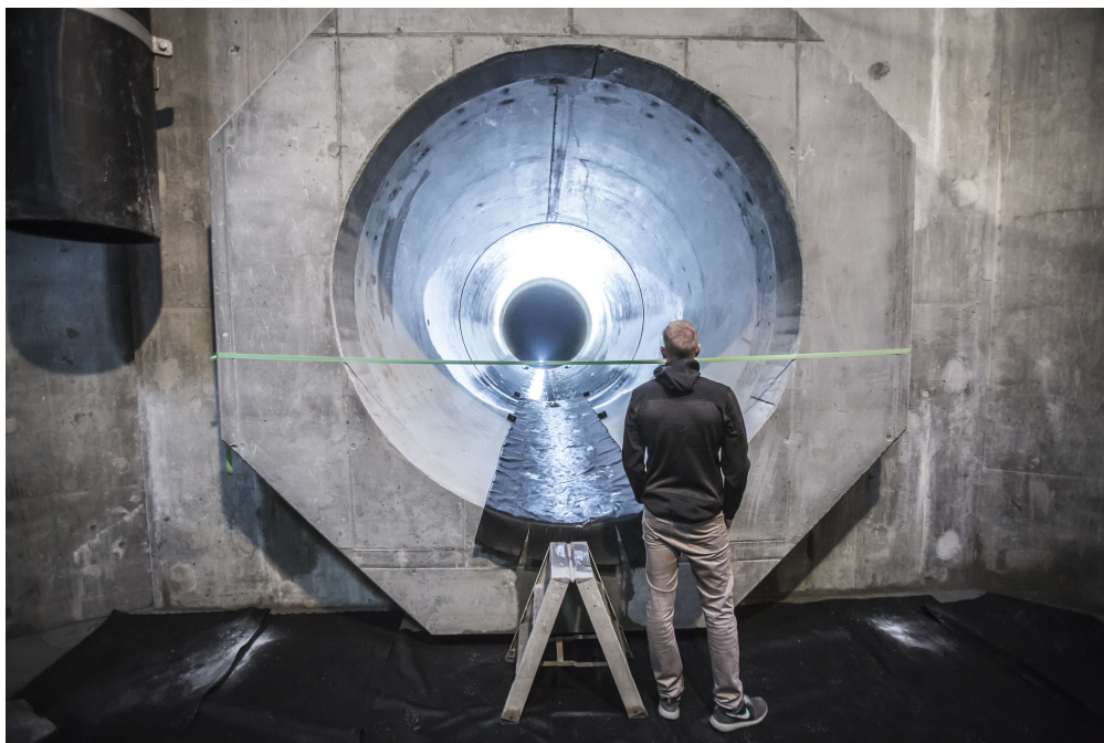
Østerbro skybrudstunnel. Foto: HOFOR
