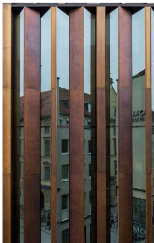
Eksempel på facadeparti med metal og glas: Joseph Pschorr Haus, München. Arkitekt: Kuehn Malvezzi.
