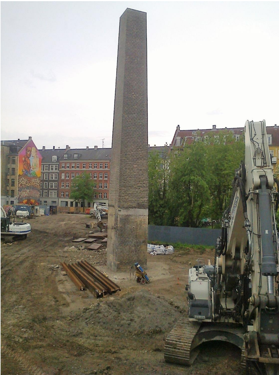
Skorsten efter afkorting, med renovering af fuger. Illustration: Ejendomsselskabet Enghaven A/S
