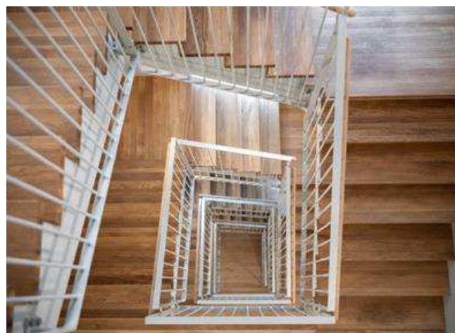
I MiniCO2 Etagehus TRÆ er der anvendt trappekerner i træ og stål. Kilde: MiniCO2 etagehus TRÆ, Realdania By & Byg, 2024.
