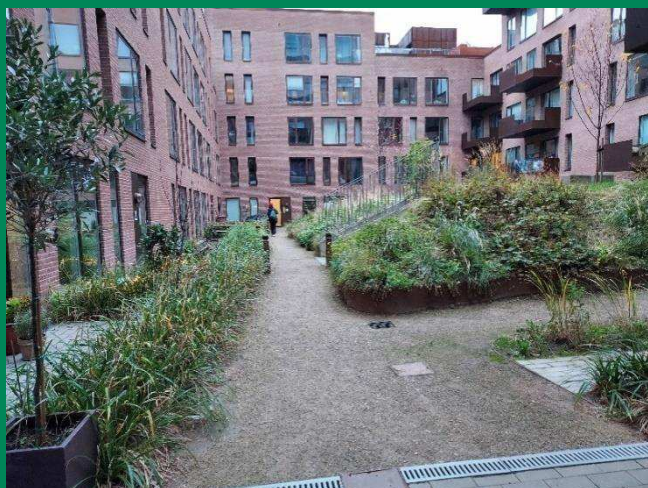
Karré i Nordhavn. Cykelparkering er valgt overdækket med en beplantet konstruktion, der fylder hele gården, hvilket understøtter arealer til bynatur, men reducerer anvendeligheden.
