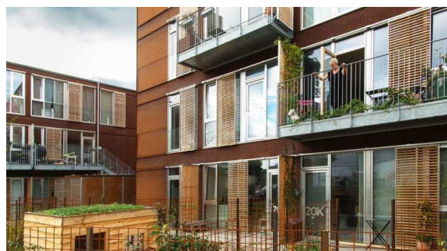
AlmenBolig+ projektet Sundholm Syd er et eksempel på et modulbyggeri, der kan skilles ad og opføres på ny. Kilde: Sundholm Syd. Scandibyg, 2015.
