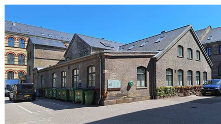
Bygning 20. Kedel- og maskinhus.
