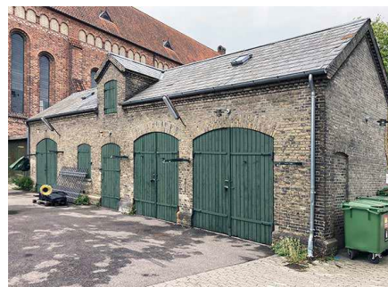
Bygning 11. Stald og gartnerbolig.
