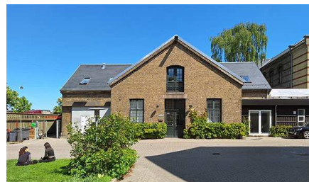
Bygning 6. Ishus og desinfektionsbygning.
