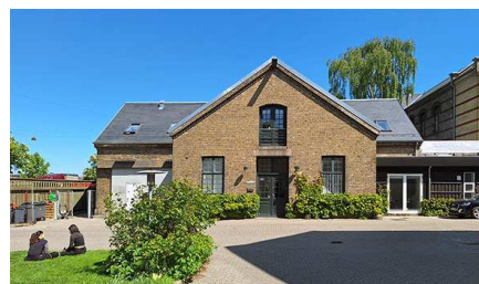
Bygning 6. Ishus og desinfektionsbygning.
