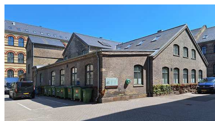
Bygning 20. Kedel- og maskinhus.
