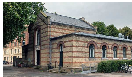
Bygning 22. Kapel og lighus
