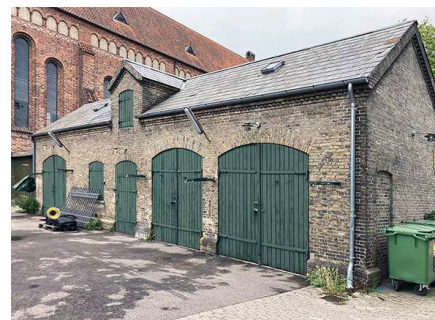
Bygning 11. Stald og gartnerbolig.
