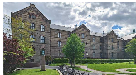
Hovedanlæg, Mandehaven med bygning 4.
