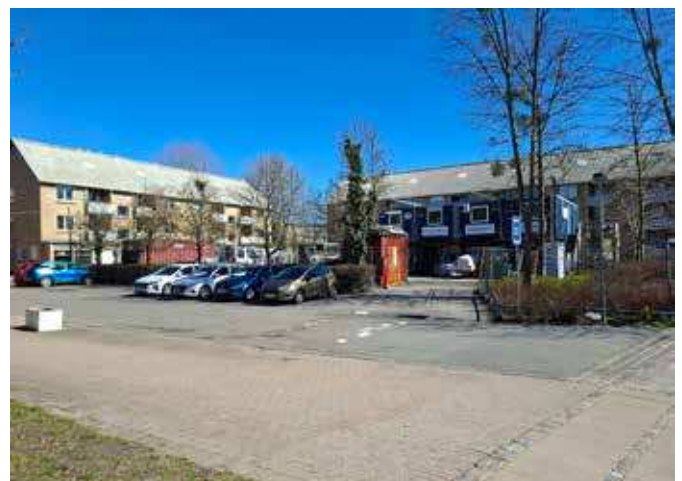
Voldparken Torv benyttes til byggeplads frem til 2028.
