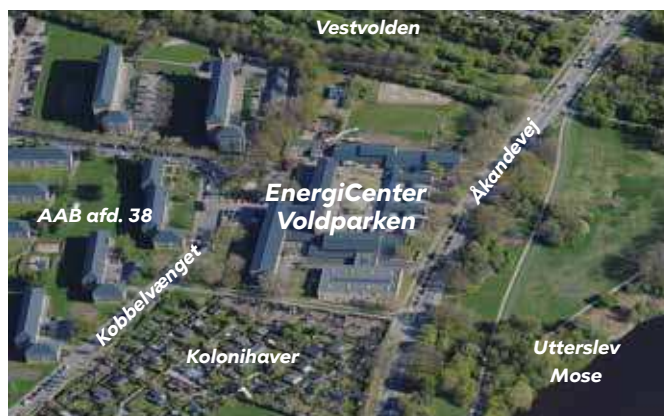
Oversigtsfoto af EnergiCenter Voldparken.
