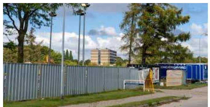
Bystævnet præges af byggearbejdet i Bystævneparken.
