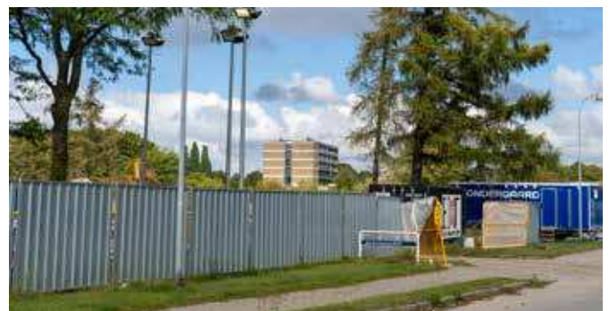
Bystævnet præges af byggearbejdet i Bystævneparken.
