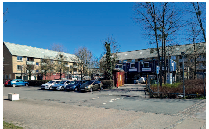
Skure og afspærringer på Voldparken Torv i 2026
