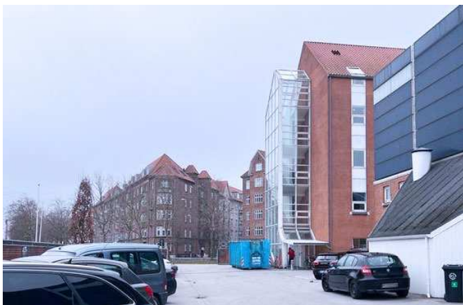
Foto, der viser den bygning der nedrives.
