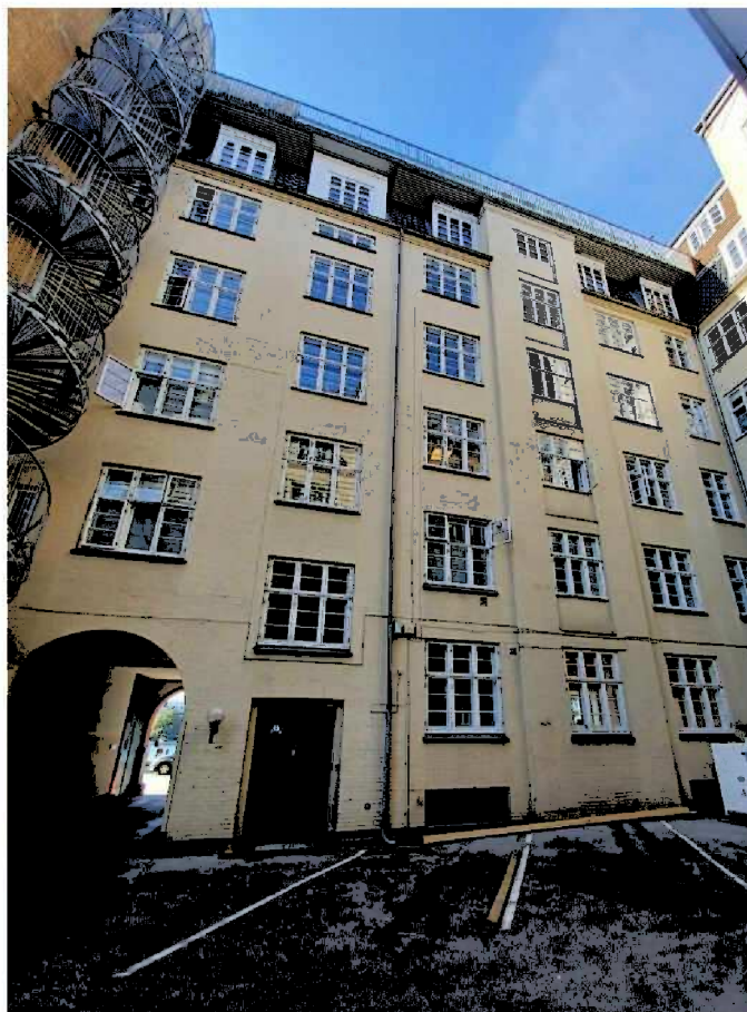
Forhusets facade set fra gårdrummet.
