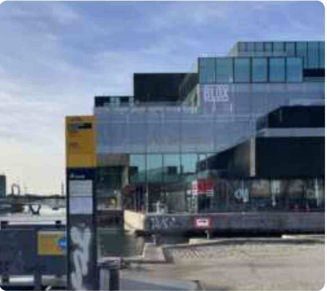
BLOX (Uden bevaringsvurdering) - BLOX ligger lige uden for pladsen. Det er et multifunktionelt hus, hvor bl.a. Dansk Arkitektur Center hører hjemme. BLOX stod færdig i 2018 og er opført og ejet af Realdania By & Byg. Med BLOX fik pladsen endelig sin tredje kant.
