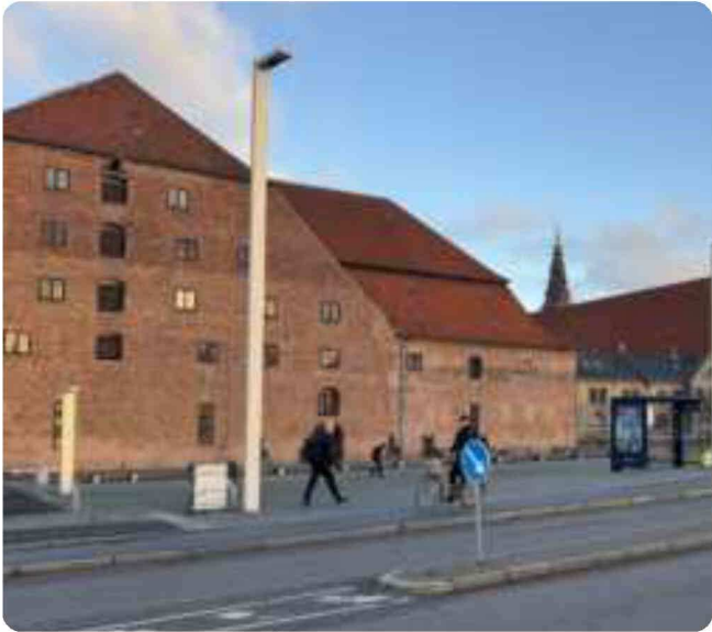
Christian 4.s Bryghus (Fredet Bygning / Høj bevaringsværdi, niv. 1) I 1618 under Christian 4. blev bryghuset indrettet i en tidligere bastion, den nu historiske bygning ud til pladsen. I Bryghuset ligger museet Kongernes Lapidarium, hvor besøgende kan gå på opdagelse blandt knap 400 originale skulpturer og gipsafstøbninger.
