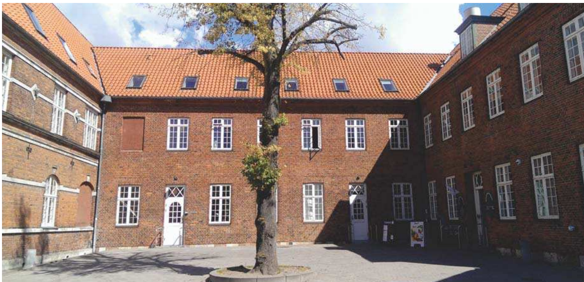
Karens Mindes indre gårdsplads, med nuværende hovedindgang inde i hjørnet. Arealet og den tilstødende "gårdsplads" kan nemt opgrades og indbyde til ophold.
