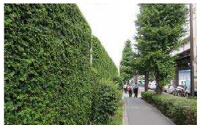
Fig. 7. Referencefotos: Eksempler på grøn lyd-absorberende støjskærm. (Foto: Entasis).
