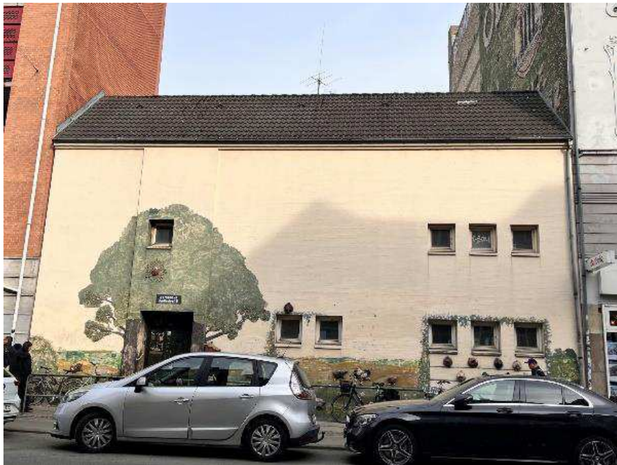
1 Foto taget af forvaltningen. Billede af bygningen, som ønskes nedrevet.
