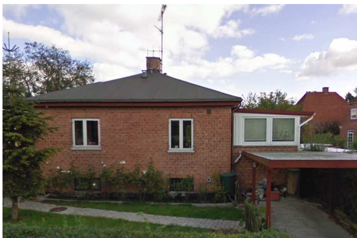
Foto 2: Foto fra Google Street View, oktober 2010
