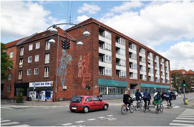
Islandsgården set fra hjørnet af Sundholmsvej og Tingvej.
