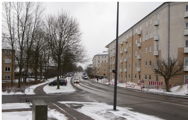
Facader mod Gadelandet på almene boliger umiddelbart vest for lokalplanområdet.
