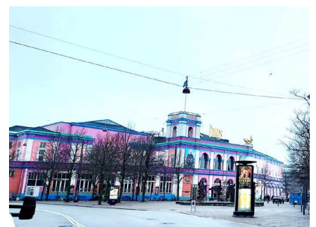
Eksisterende facade mod sydøst
