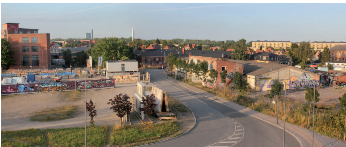
Adgangsvejen til den nordlige stationsforplads med de to ejendomme på hver side, hvor lokalplantillægget justerer bestemmelser om anvendelse og bebyggelsesplan. På ejendommen øst for vejen står bebyggelsen tom.
