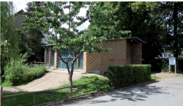
Den tidligere skolepedelbygning, der ligger ud mod Vanløse Allé, bruges i dag til faglokale. Karakteristisk for bygningen er facadernes fine mønstermurværk.
