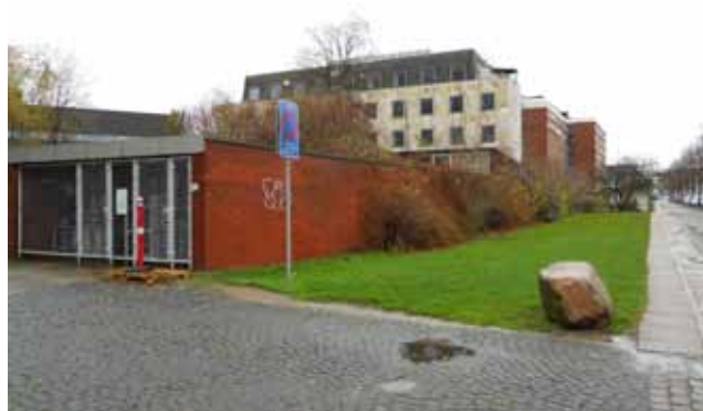
Byggefeltet set fra Nørre Allé med Bygning 17 bagerst. De lave bygninger forrest skal nedrives.
