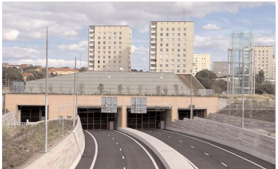
Södra Länken i Stockholm, tunneludmunding med glasskorsten til forurennet tunnelluft
