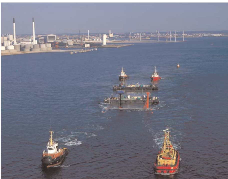
Transport af sænketunnelelement til Øresundsforbindelsen.
