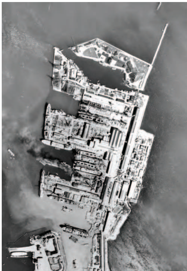
Lodfoto af Refshaleøen fra 1954. Skibsværftet i de gode dage, hvor alle beddinger blev anvendt til skibsbygning. Få år senere blev vandarealerne mod øst opfyldt, og dermed indledtes en tid med nye skibstyper og nye produktionsmetoder.
