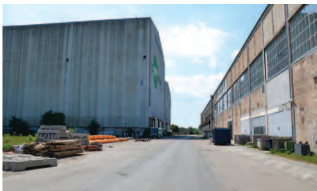
Bygningsproportionerne er store på Refshaleøen. Her mødes det gamle og det nye skibsværft med den gamle svejsehøle til højre og sektionshallerne til venstre.
