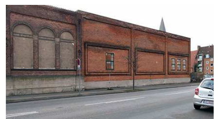
Tagensvej 85 – Spinderibygning II.
